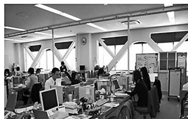
耐震補強の例 筑波大学中央
