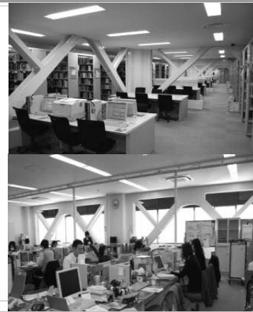
耐震補強の例 筑波大学中央
