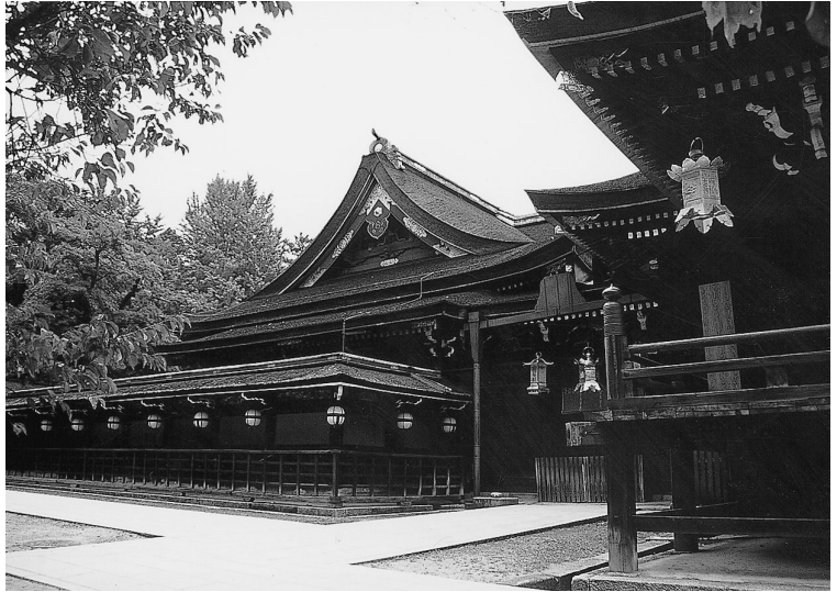
1100年忌の平成14年に修復された北野天満宮社殿
