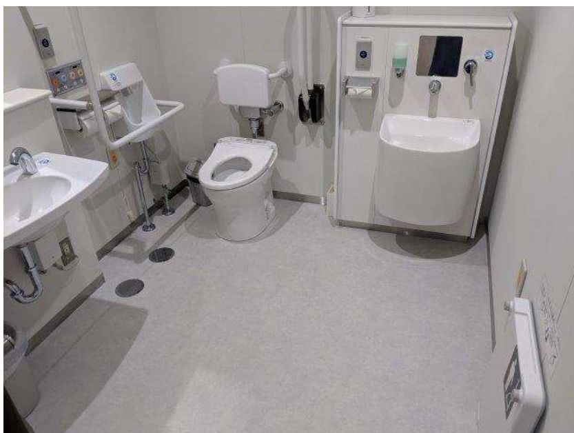
Figure 3 オストメイト対応・チェンジングボード付き多目的トイレ
