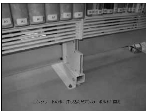
コンクリートの床に打ち込んだアンカーボルトに固定
