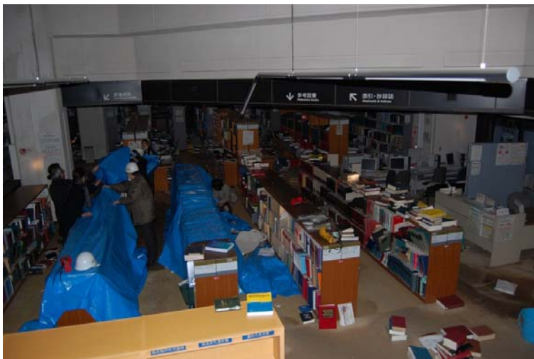
医学図書館 1 階です。余震が続く中、天井からの水漏れから資料を守るために、ビニールシートを広げました。（3 月 11 日撮影）
