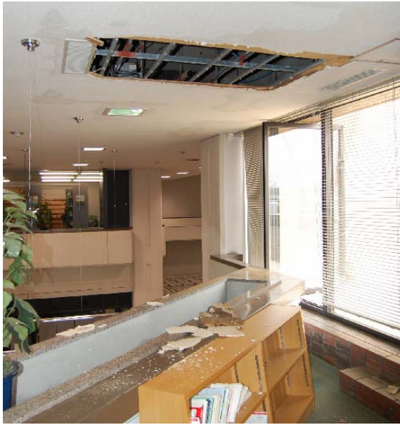
医学図書館 2 階です。天井が落ちてしまいました。(3月14日撮影)
