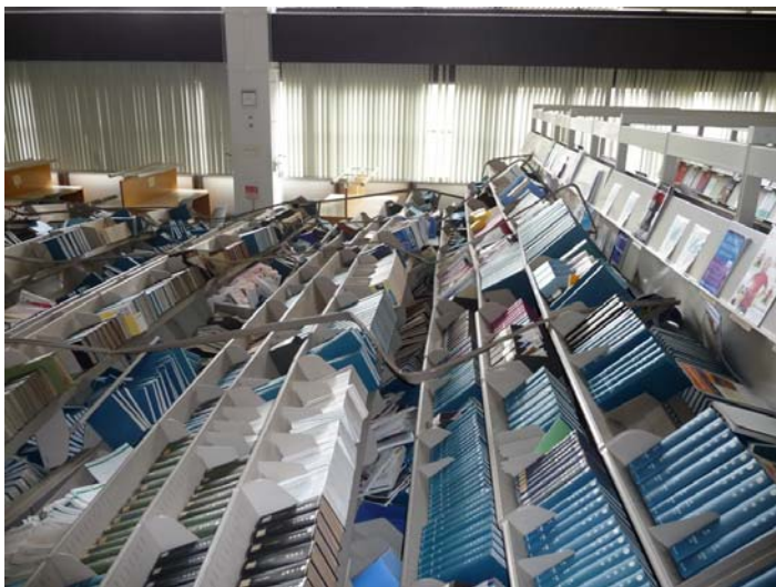
体芸図書館 1階の転倒した和雑誌バックナンバーの棚です。振れ止めが大きく歪んでいます。
