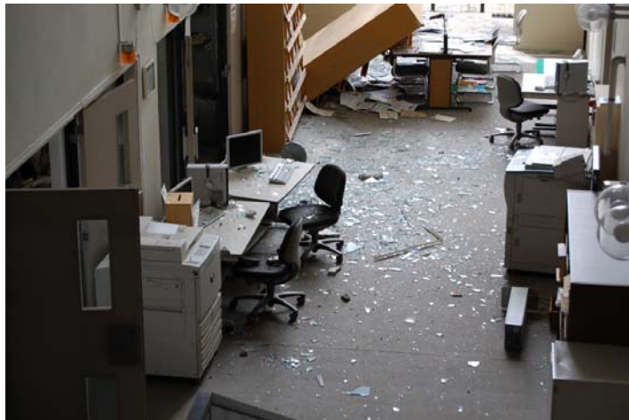
体芸図書館 1階吹き抜けです。ガラスの破片が落下していて、危険な状態です。(3月14日撮影)
