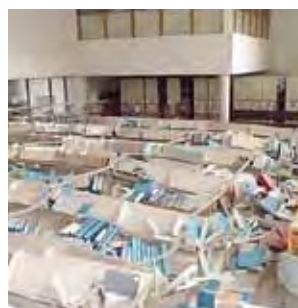
書架の倒壊 (体育・芸術図書館)
