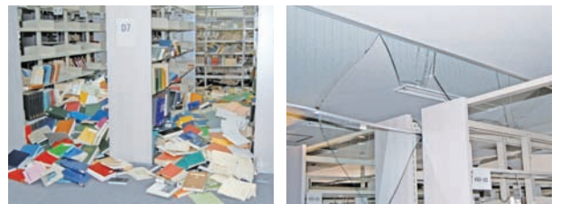
被災後の本館5階状況(2011年3月14日撮影)
